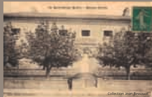
Maison d'arrêt de St-Palais. Elle sera démolie dans les années 1960, pour laisser place au marché couvert.
